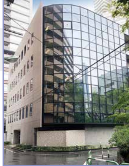
本社(第3キンズメンビル)
